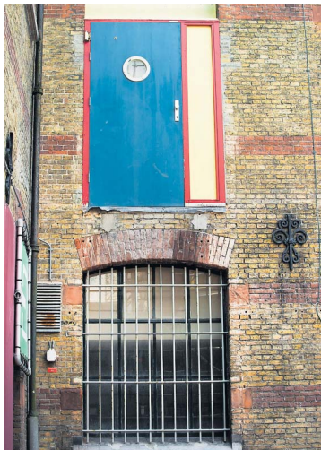
Zwevende deur die voorheen toegang gaf tot een loopbrug voor bewakers.
