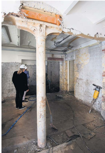
Achter een oude muur kwam een gietijzeren kolom met de oorspronkelijke beschildering tevoorschijn.
